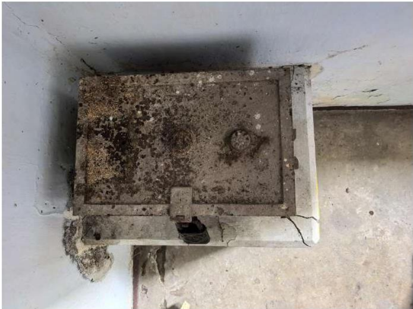
Foto 3. Brankas Tanam di Kapanewon Kalibawang (tampak atas) Sumber: Dinas Kebudayaan ( Kundha Kabudayan ) Kab. Kulon Progo, 2026
