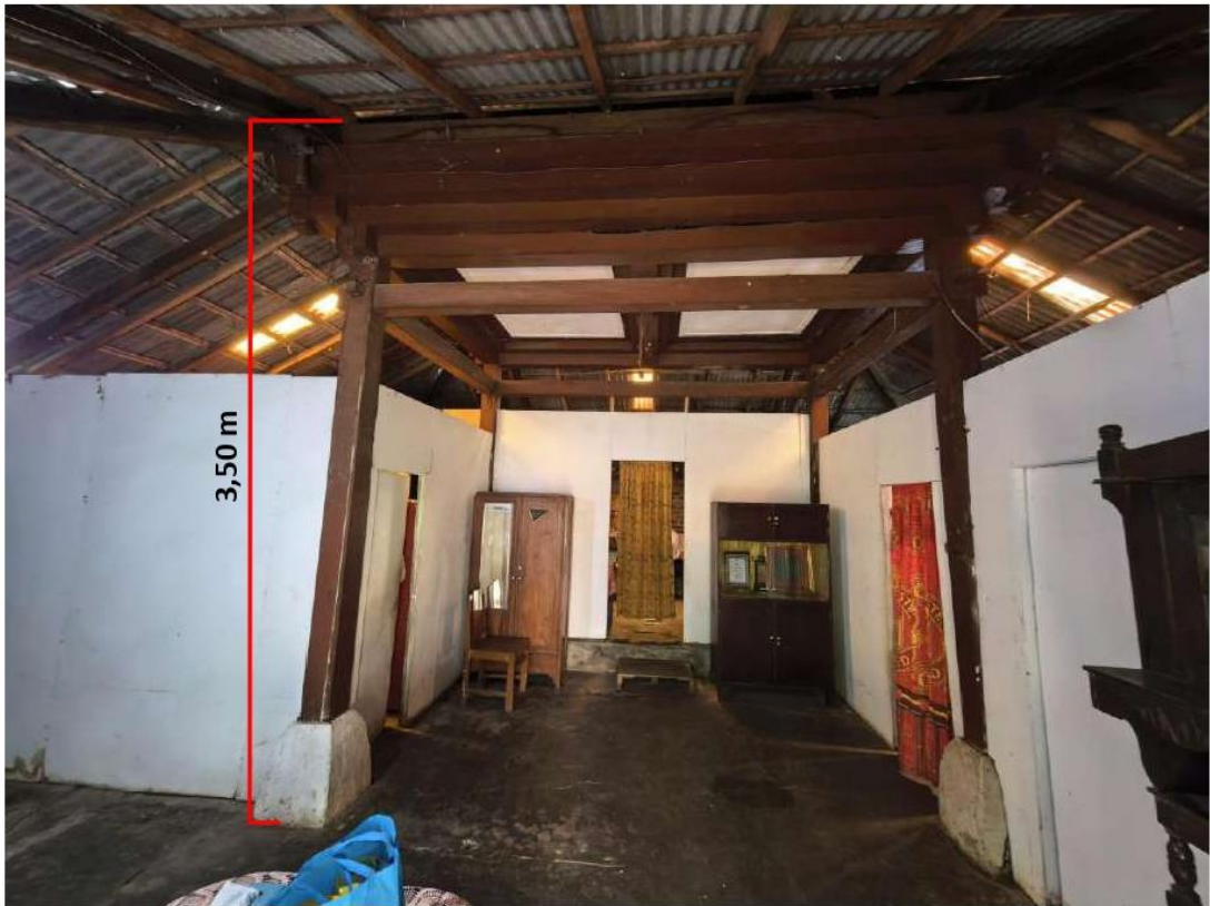
Foto 4. Tampak struktur dan tapak bangunan ( lantai bebatur ) Joglo Darmogati Sumber: Dinas Kebudayaan ( Kundha Kabudayan ) Kab. Kulon Progo, 2026
