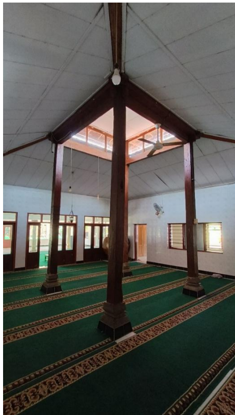
Foto 1. Struktur Saka Guru Masjid Kedondong (Sunan Kalijaga)
