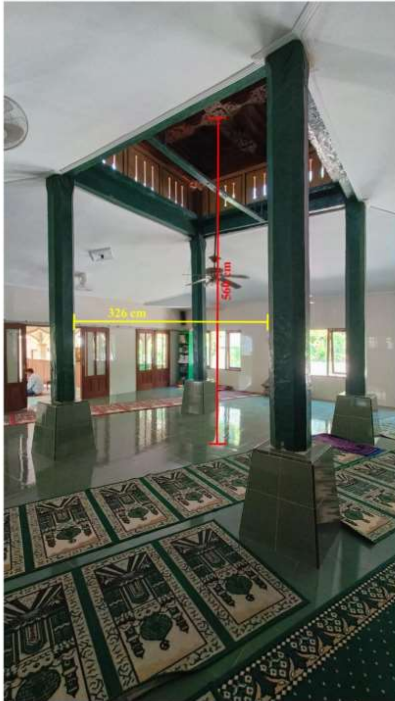
Foto 3. Ukuran Struktur Saka Guru Masjid Kedondong (Sunan Kalijaga) dilihat dari barat laut
