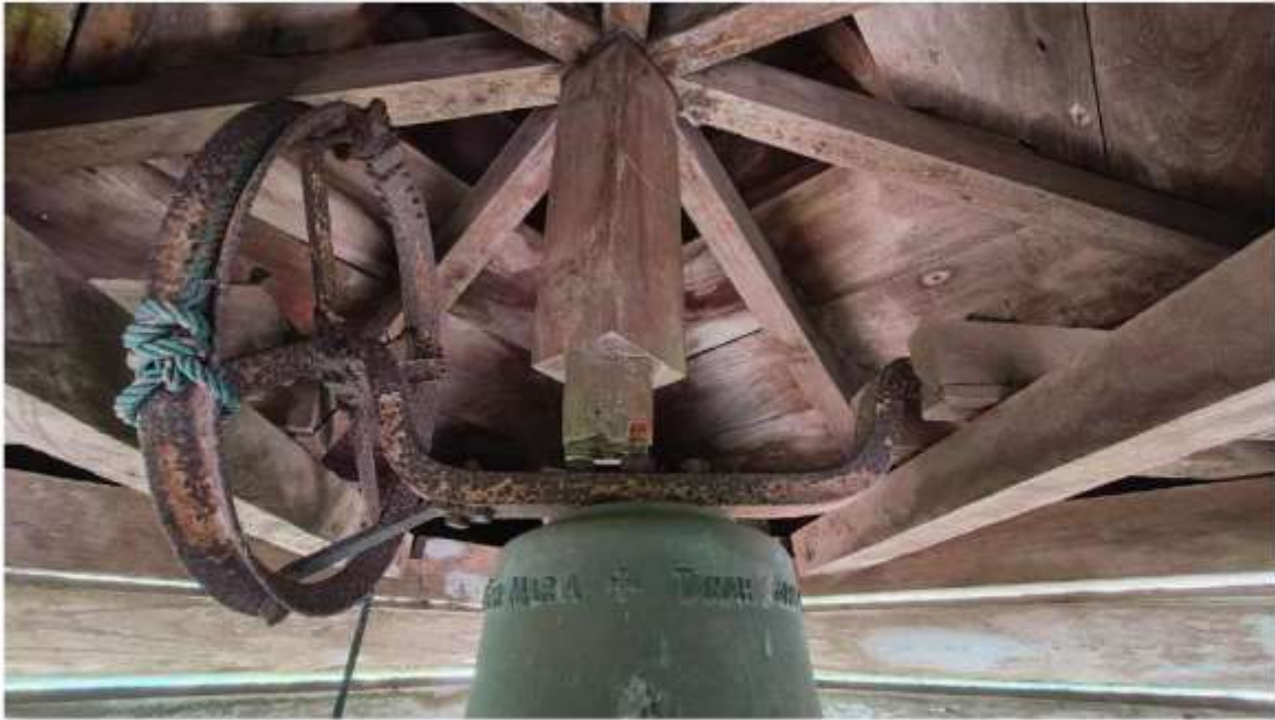
Foto 4. Tampak duduk besi dan roda putar lonceng Sumber: Dinas Kebudayaan ( Kundha Kabudayan ) Kab. Kulon Progo, 2025
