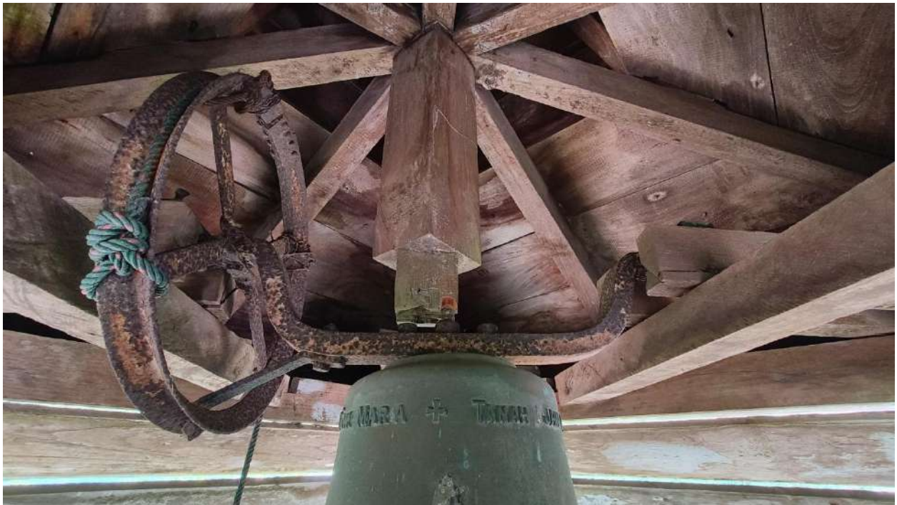
Foto 4. Tampak kedudukan besi dan roda putar lanceng
